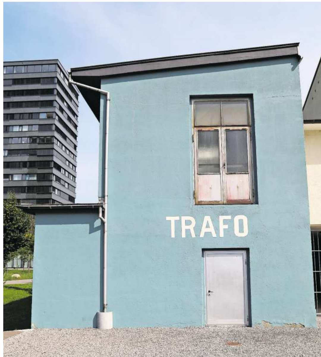
Lange blieb die alte Trafostation im Rorschacher Stadtwald ungenutzt. Nun richtet der Kunstverein dort unter anderem ein Atelier und Ausstellungsraum ein.
